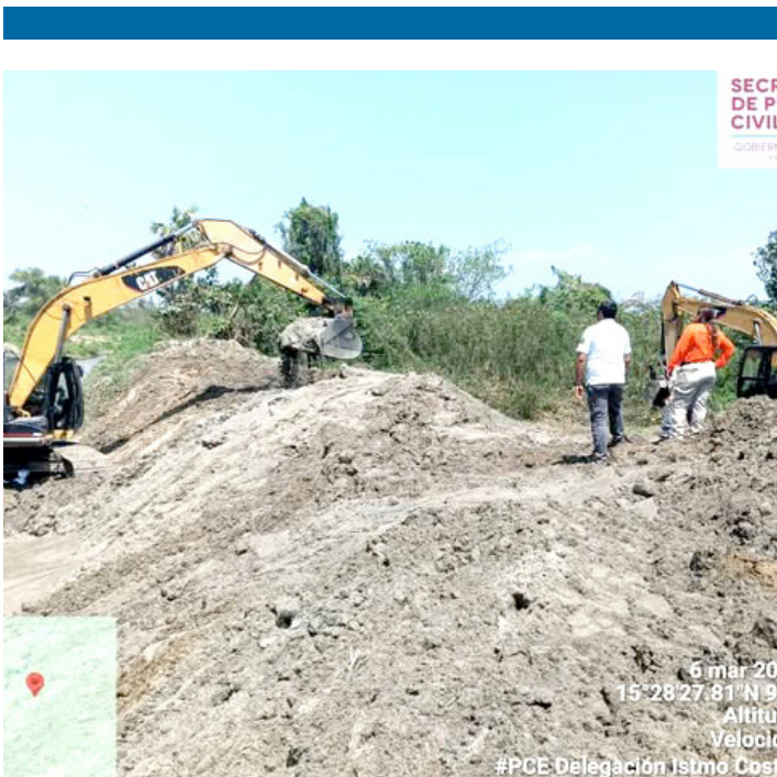
PROTECCIÓN CIVIL verifica trabajos de limpieza en tres ríos para prevenir inundaciones ante la próxima temporada de lluvias.
