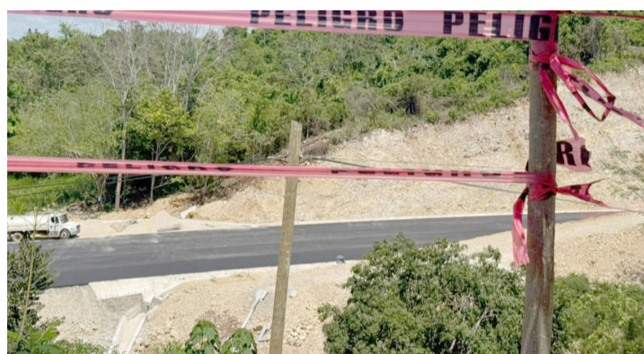
LA PRIMERA etapa de la obra que conecta Palenque con Misol-Ha muestra avances significativos.
